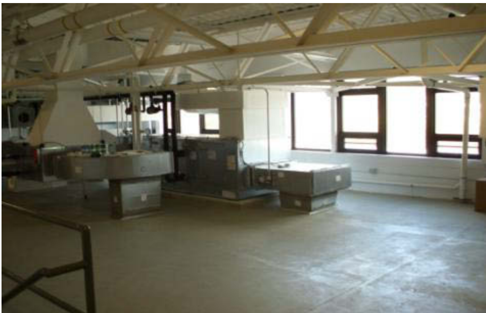
Drill Hall HVAC Fan Unit
